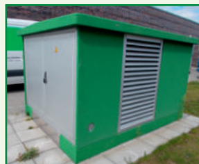
Abb. 4: Mittelspannungsstation
