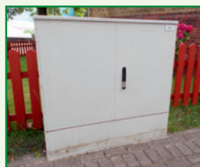
Abb. 8: Kabelverteilerkasten
