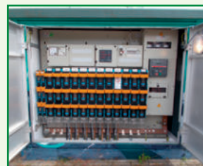
Abb. 5: Mittelspannungsversorgung
