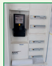
Abb. 9: Schalter im Kabelverteilerkasten
