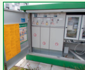
Abb. 5: Mittelspannungsversorgung
